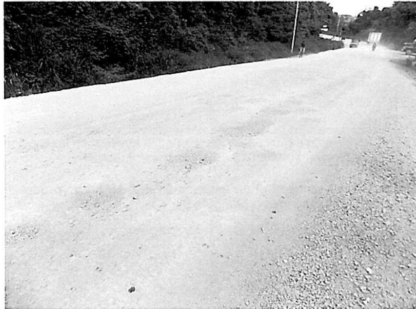
Figura 5. Deterioros presentes en la capa granular de colocación reciente. Estación 1+360. Fecha: 30/05/2018. Fuente: LanammeUCR
