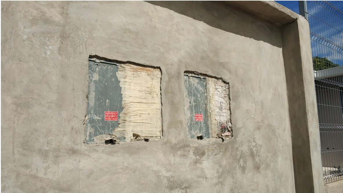
Figura 11. Mocheta de bases de medidores.
