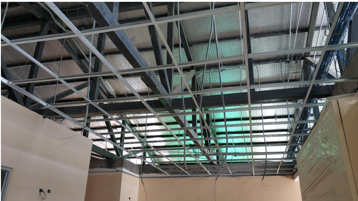
Figura 10. Vista del cielo en sala de espera
